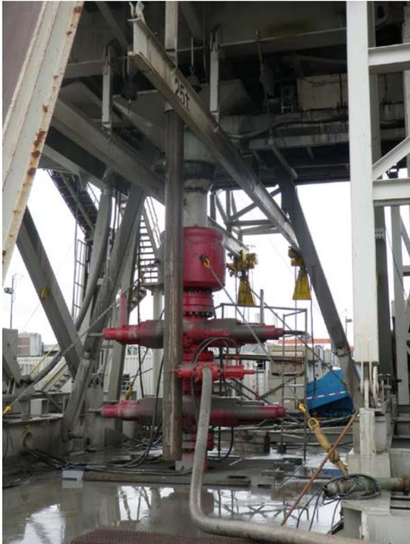
**Abb. 5** Blowout-Preventer (rotes Teil) einer Erdgasbohrung der Oranje-Nassau Energie mit einer T-45 EMSCO C2-II der KCA Deutag in Rotterdam (Foto Keller + Lorenz AG). Mit dem Blowout-Preventer lässt sich bei einem unkontrollierten Gasaustritt der Bohrlochmund per Knopfdruck hermetisch verschliessen.
