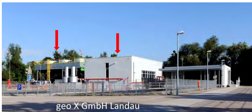
Figur 17: Petrothermale Anlage in Landau, Deutschland. Luftkühlung links und Kraftwerksgebäude Mitte (Quelle: geo X GmbH, Landau).
