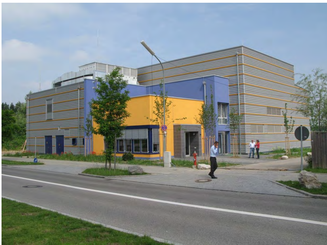
Figur 19: Geothermie-Kraftwerk Unterhaching, Südbayern.
