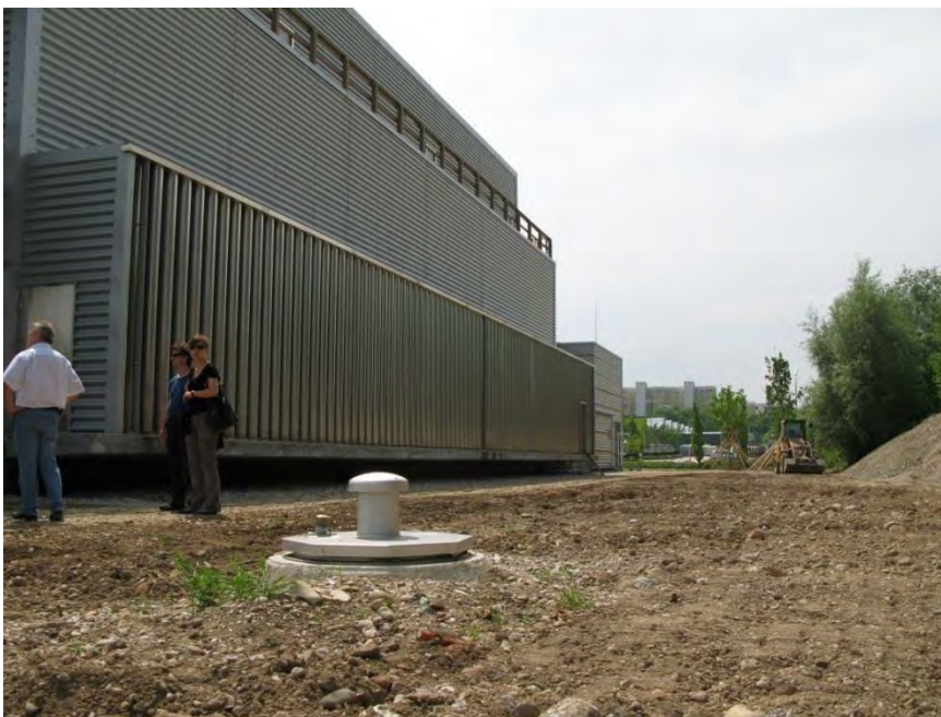
Figur 21: Kühlanlage des Geothermie-Kraftwerks Unterhaching, Südbayern. Blick auf die Westfassade. Im Vordergrund ein Grundwasserbrunnen für die Kühlwassergewinnung.
