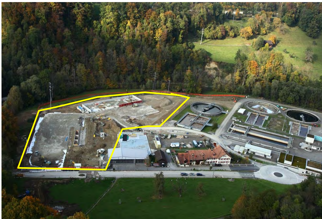
Figur 18: Teilweise fertig gestellter Bohrplatz in St.Gallen (gelbe Markierung). Blick Richtung Nord. (Quelle: Sankt Galler Stadtwerke, 2011).
