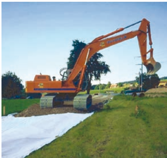
Kiepisten sind eine geeignete lastverteilende Massnahme zur Vermeidung von Verdichtungen.
