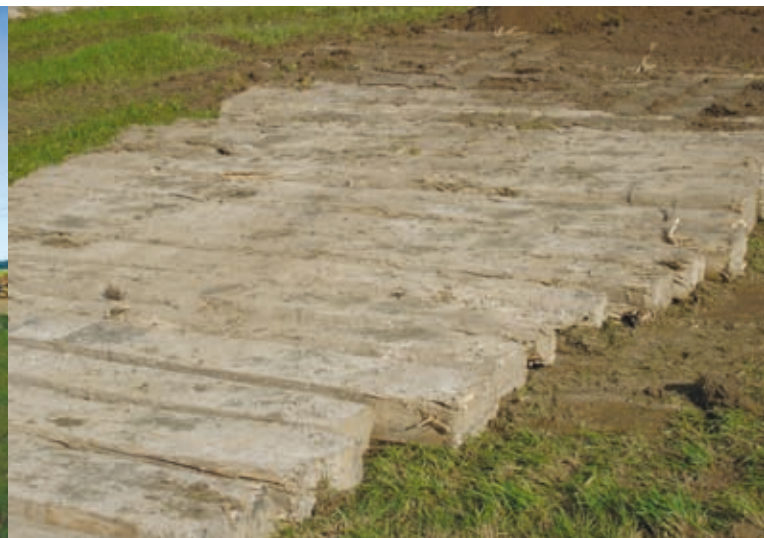
Baggermatratzen sind leicht verstellbar und eignen sich für kleinere und temporäre Einsätze.
