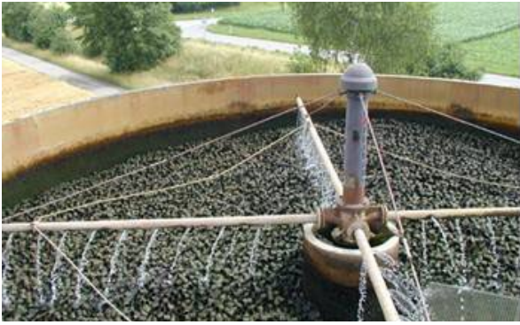
Abbildung 28: Tropfkörperverfahren (links) und Scheibentauchtropfkörper (rechts)
