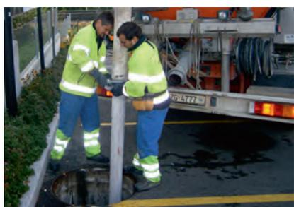
Abb. 3 Oben: Absetzbecken der einstufigen SABA. Mitte: Akkumulierter Schlamm. Unten: Absaugen der akkumulierten Schlammmenge.
