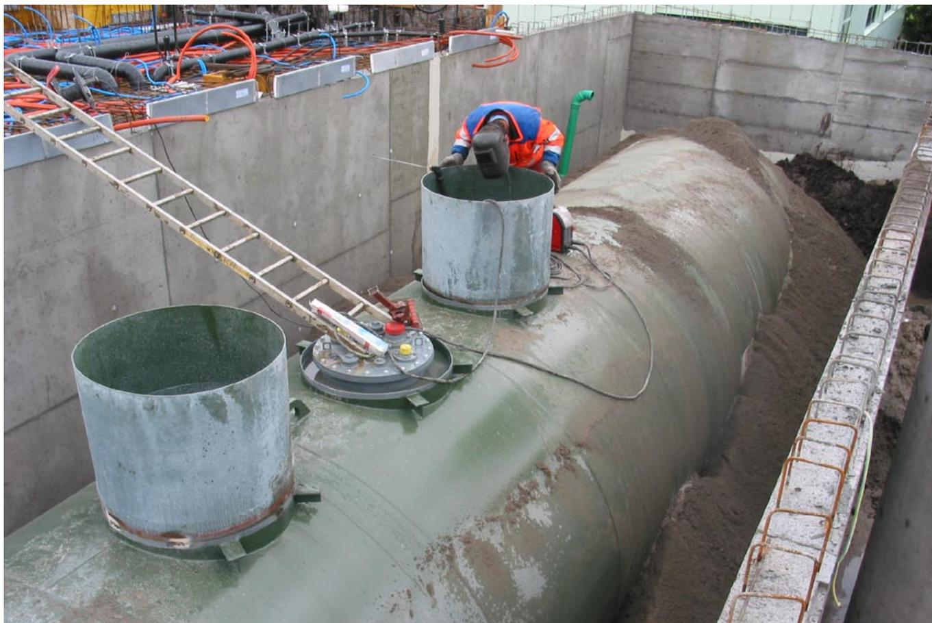
Einer der grössten im Kanton Zug verlegten Diesel- und Benzintanks
