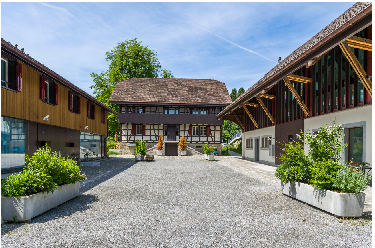
2 Wohnüberbauung Hammergut, Cham
