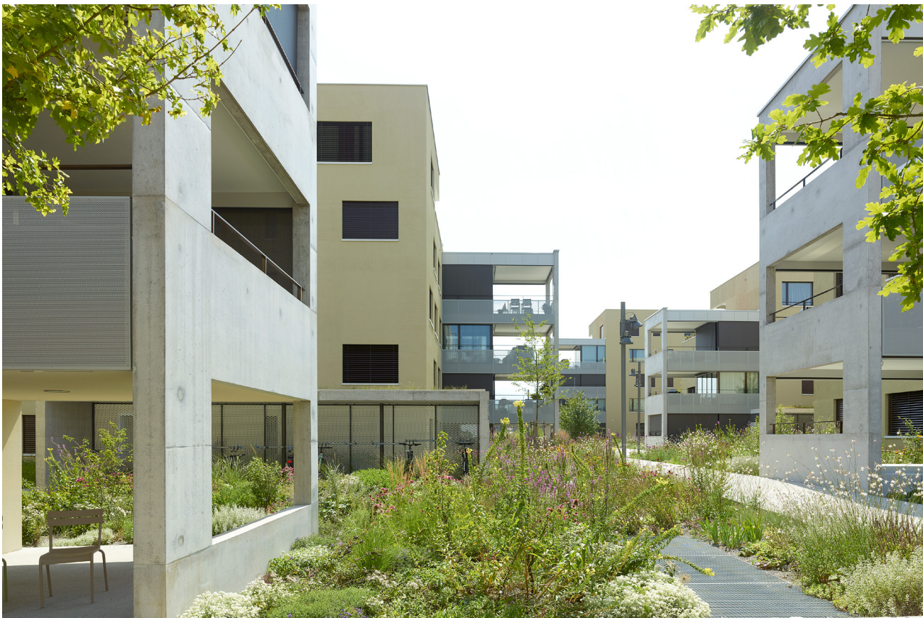
1 Wohnsiedlung Obermühleweid, Cham
