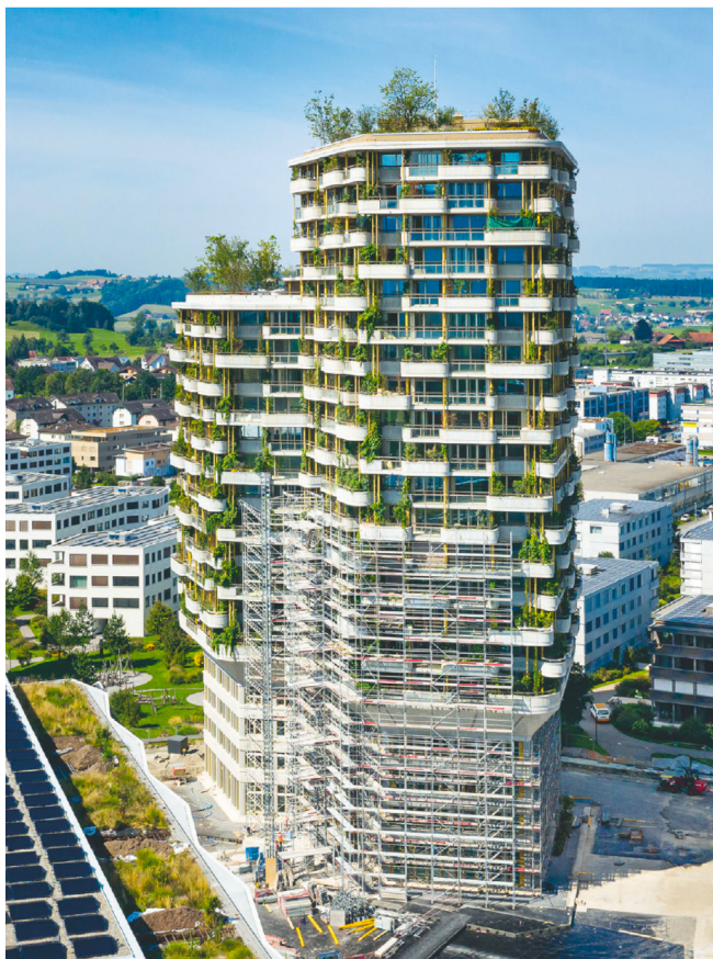
4 Gartenhochhaus «Aglaya», Suurstoffi, Rotkreuz
