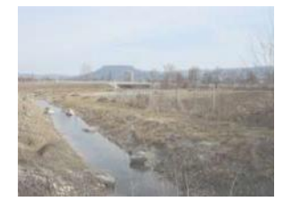
Alte Lorze im Bereich der Renaturierung an der A 4a
