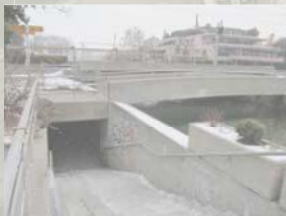
Situation Unterführung an der Neuen Lorze
