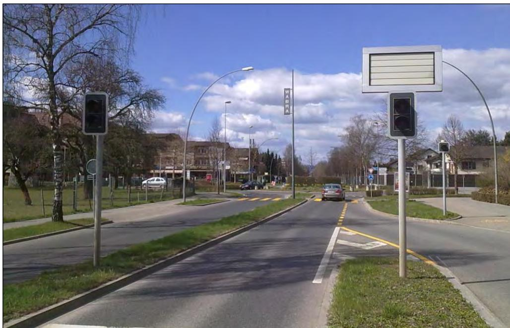
Abbildung 39 Beispiel einer Dosierungsanlage in Kleinwabern/BE (Foto: Gruner)
