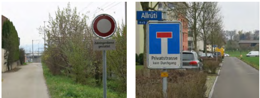
Abbildung 19: Ungünstige Signalisation für Fuss- und Veloverkehr (Beispiele Binzmühlestrasse, Allrütli)
