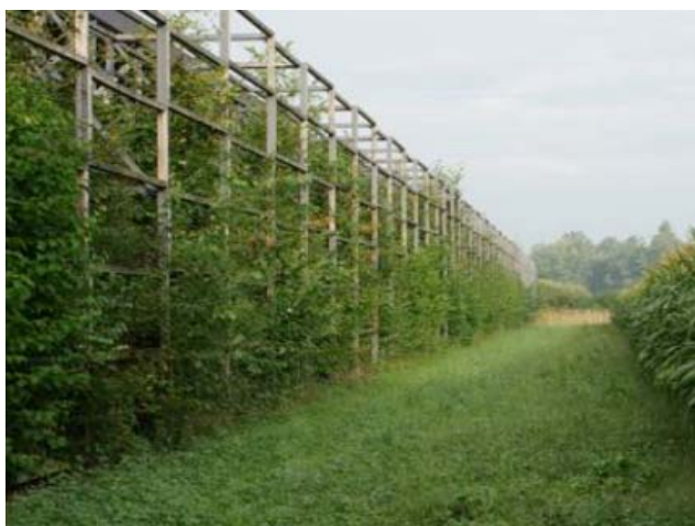
Abbildung 3: Vegetationswand an der Westseite der bestehenden Produktionshalle
