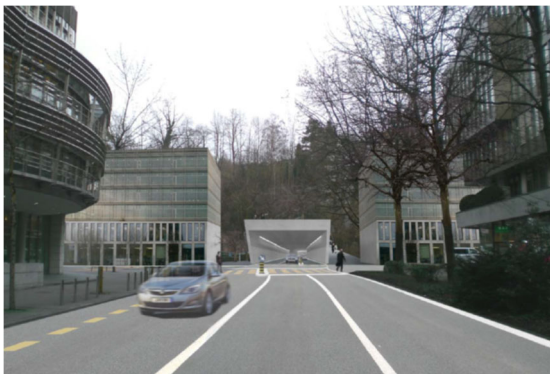
Abbildung 42: Varianten der Tunnelportale (Bilder aus ZMB 2011): Oben Artherstrasse, Mitte Gubelstrasse, Unten Gotthardstrasse
