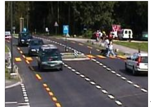
Abb. 93-98: Die Velofahrenden queren die Strasse auf verschiedenste Arten: Über den Fussgängerstreifen zu Fuss oder fahrend, via Mittelzone auf dem Veloweg oder auf dem Radstreifen weiter. Insgesamt hat sich die Situation deutlich verbessert.
