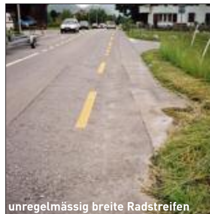
Schäden am Deckbelag der Viehweidstrasse im Bereich des Radstreifens
