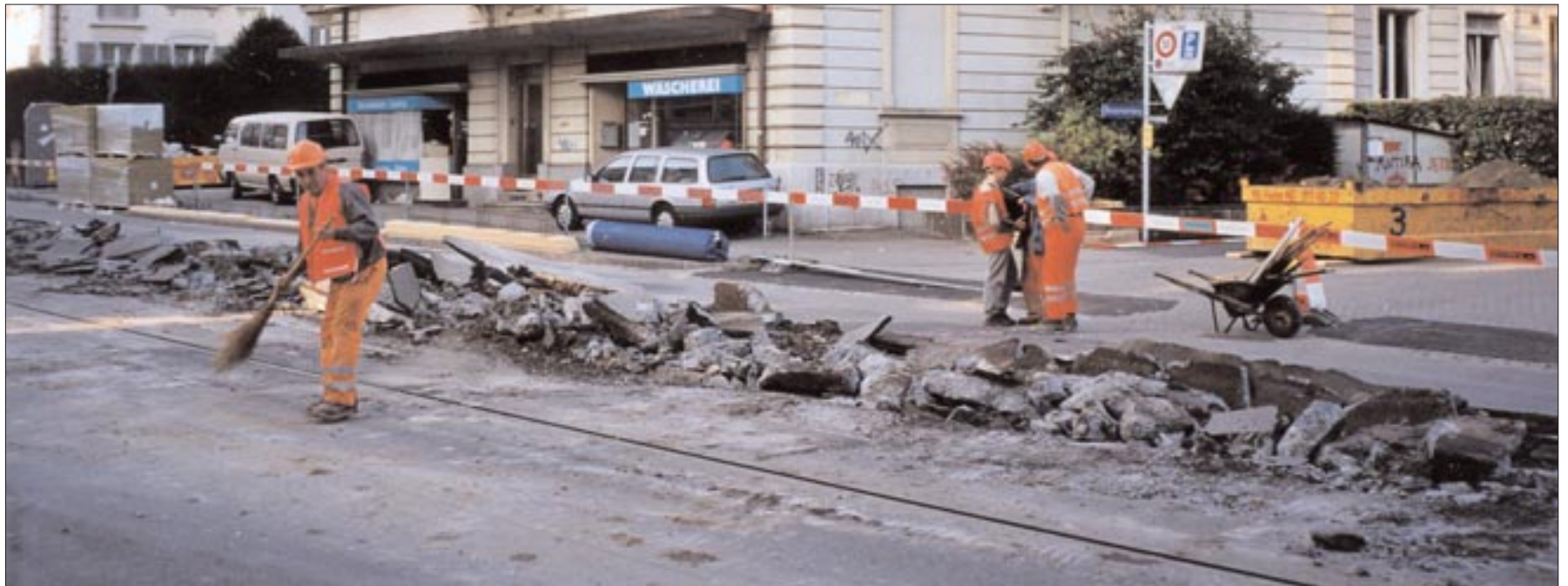
16 verkehrsteiner MONTABER ZERKLEINERT BETONPLATTEN Sanierung Seftigenstrasse Bern 2002
