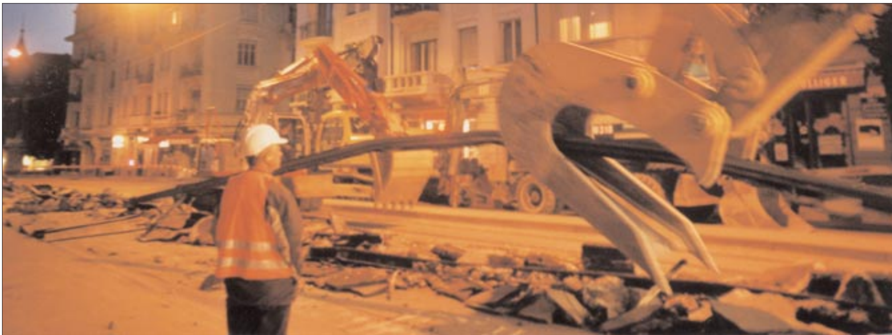
Sanierung Seftigenstrasse Bern 2002 85 TONNEN GLEISHOBEL AM WERK
