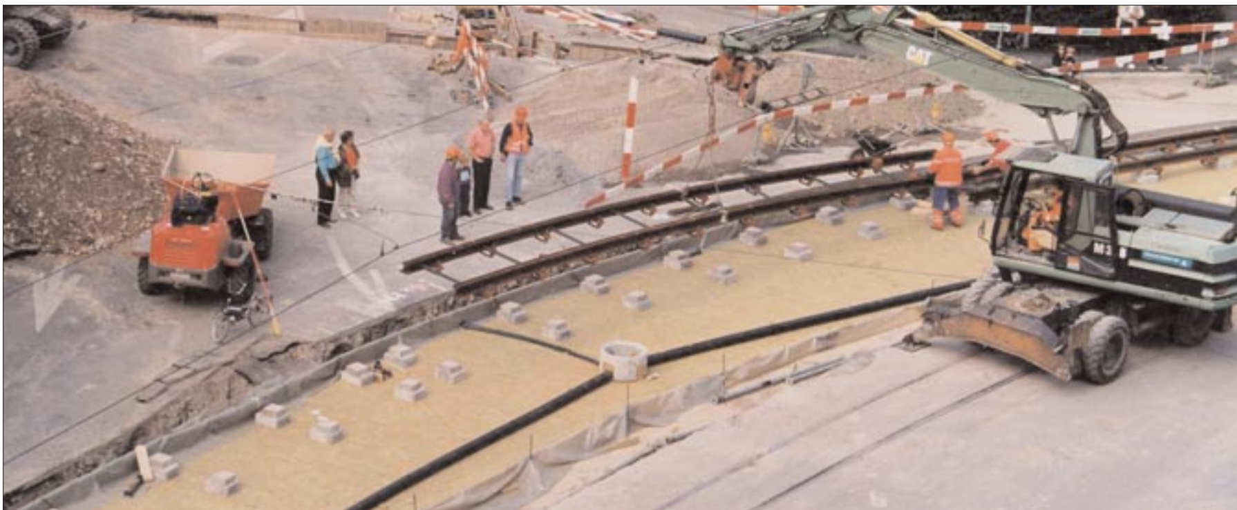
Sanierung Seftigenstrasse DÄMMPLATTEN SENKEN LÄRM+ERSCHÜTTERUNG verkehrsteiner 19
