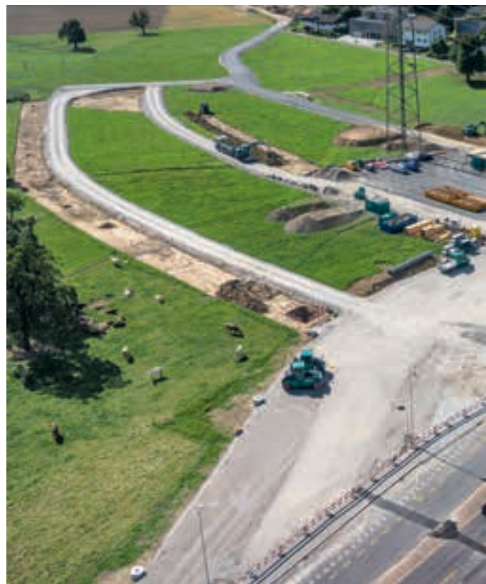
Der Knoten Neufeld wurde nach Osten verlegt, damit eine neue Strassennut (Bild: Baudirektion Kanton Zug / Andreas Busslinger)
