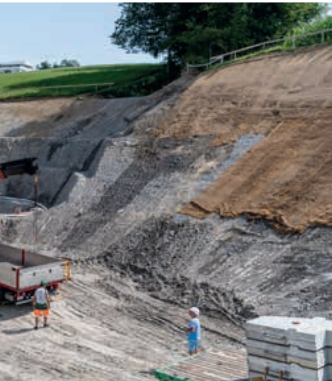
ufts der Ägerstrasse wird die Tunneleinfahrt erstellt
