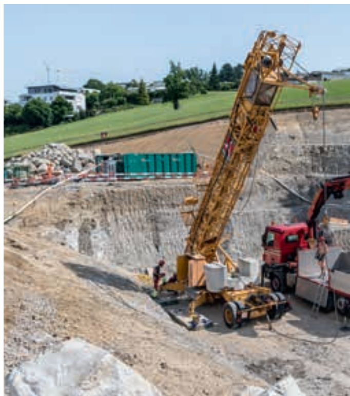
Margel: Die Ägeristrasse wird hier abgesenkt. Westlich des heutigen Verlaufs (Bild: Baudirektion Kanton Zug / Andreas Busslinger)
