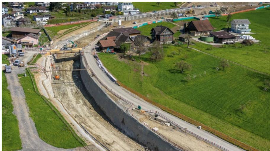
Der Geissbuel-Tunnel wird im Tagbau errichtet. Die Baugrube ist 370 Meter lang und wird bis auf eine Höhe von 12 Metern ausgehoben.
