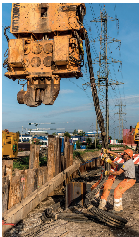
Die Spundwände werden einvibriert.
