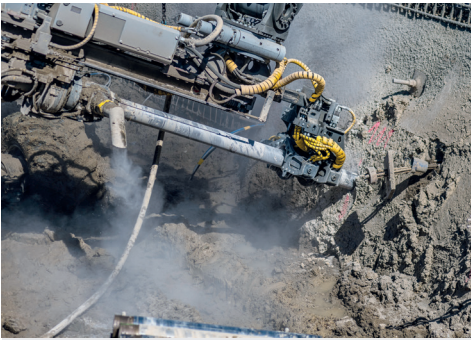
Oben: Eintreiben der 12 Meter langen Nägel. Unten: Das aus dem Boden herausgeholte Material wird vor Ort mit einem Brecher recycelt.
