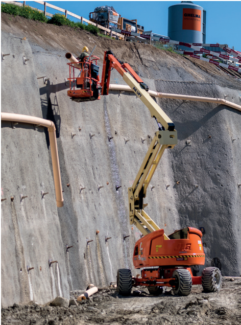
Die Baugrubenwände werden mit rund 2000 Bodennägeln und Ankern verstärkt.
