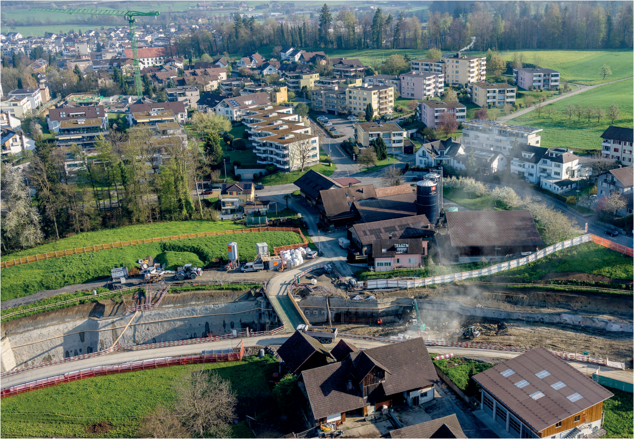
Der Geissbüel-Tunnel wird auf einer Länge von 370 Metern im Tagbau erstellt.
