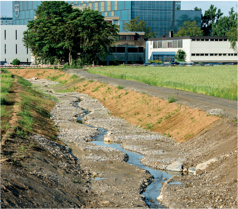
Im Zuge des Ausbaus konnte der Grossacherbach im Gebiet Göbli renaturiert werden.
