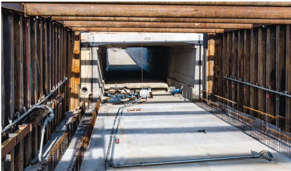
Spundwände schützen die Baugruben der Unterführungen Zuger- und Südstrasse vor dem Eindringen des Grundwassers
