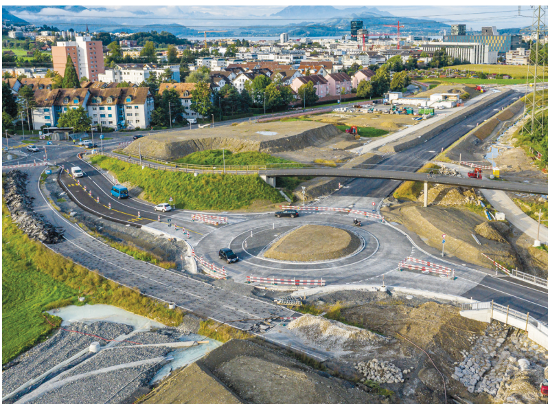
Die drei Kreisel der Tangente Zug/Baar sind bald fertiggestellt
