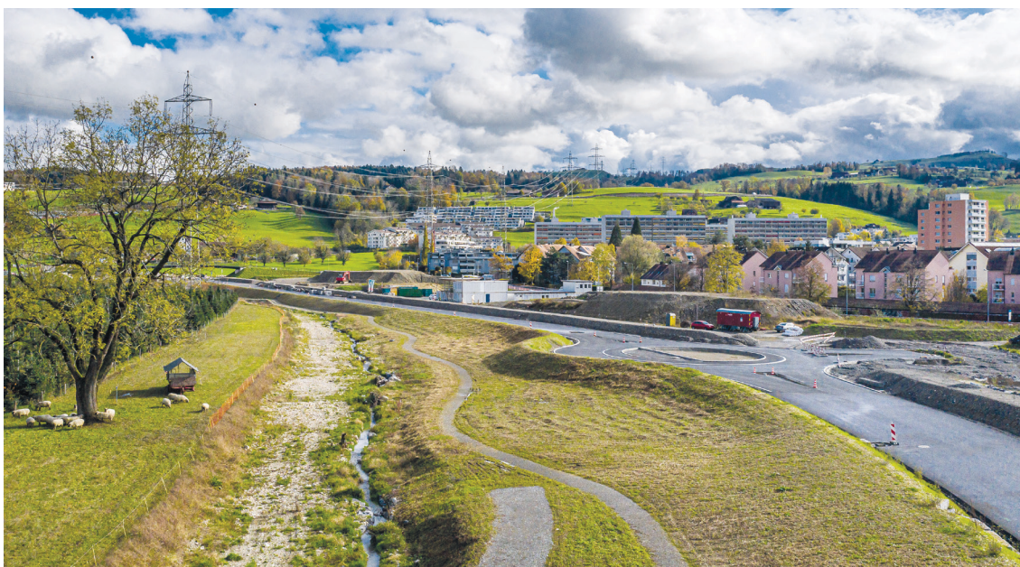
Die vor dem Verkehrslärm schützenden Dämme werden noch mit Schallschutzelementen ergänzt
