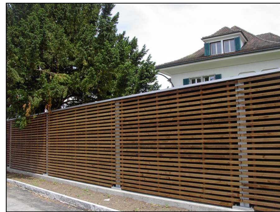
Beispiel Lärmschutzwand Neugasse (Quelle: Wenger Holzbau AG)
