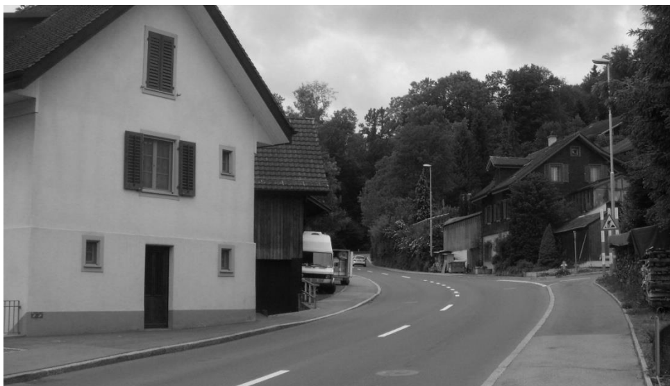
Blickensdorferstrasse 23 und 28: kein Platz für Lärmschutzmassnahmen
