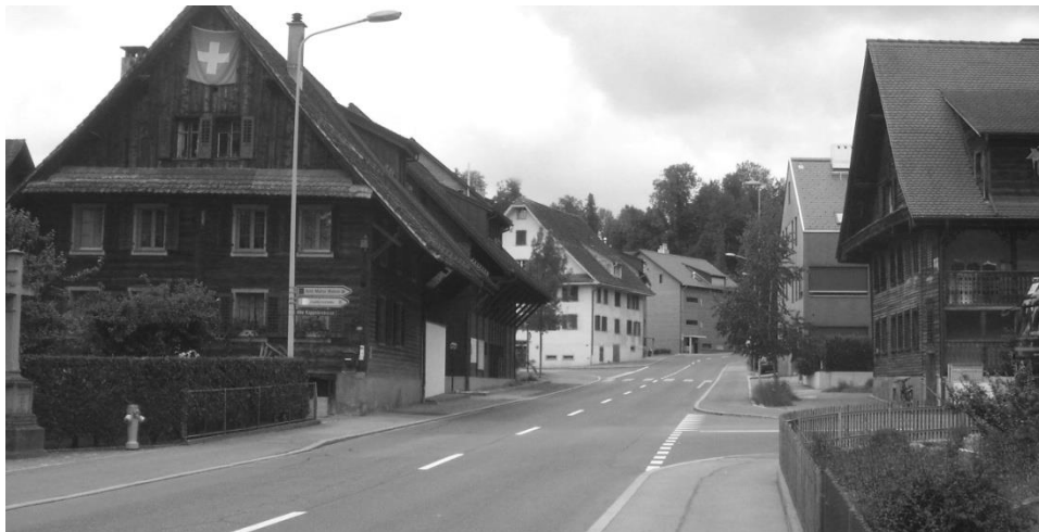
Blickensdorferstrasse 13-19 / 14-18: Ortsbild wäre mit Lärmschutzwänden stark beeinträchtigt
