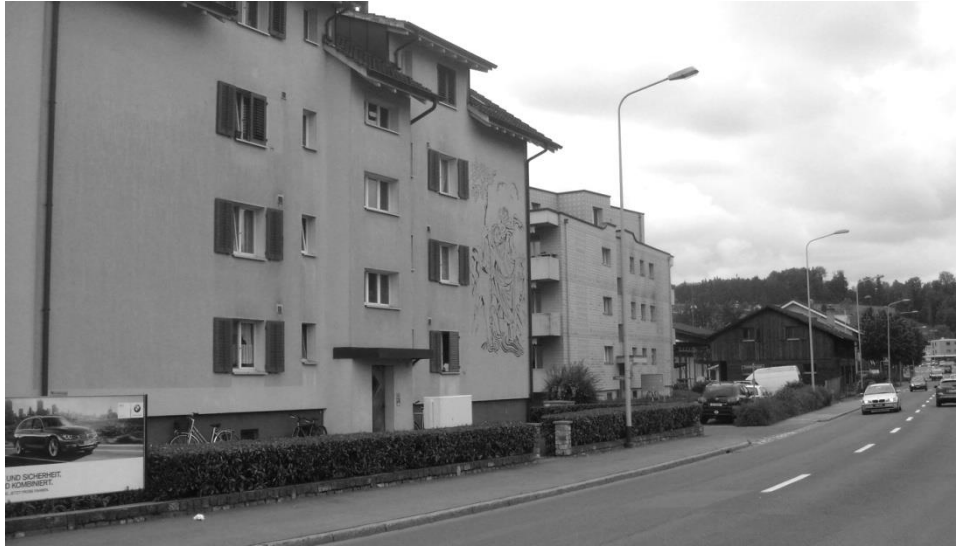
Neugasse 35/37: Wandhöhen über 5 m erforderlich, Zugang und seitliche Einfahrt würde abgeriegelt
