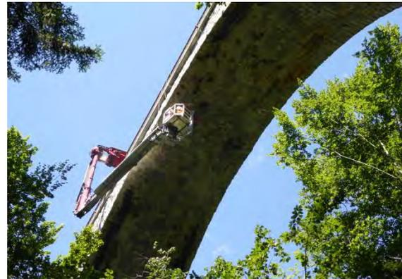
Abbildung 13: Bohrkernentnahme im Gewölbe 4
