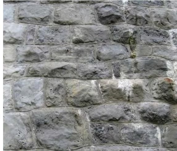
Abbildung 11: Bruchsteinschichtenmauerwerk Pfeiler
