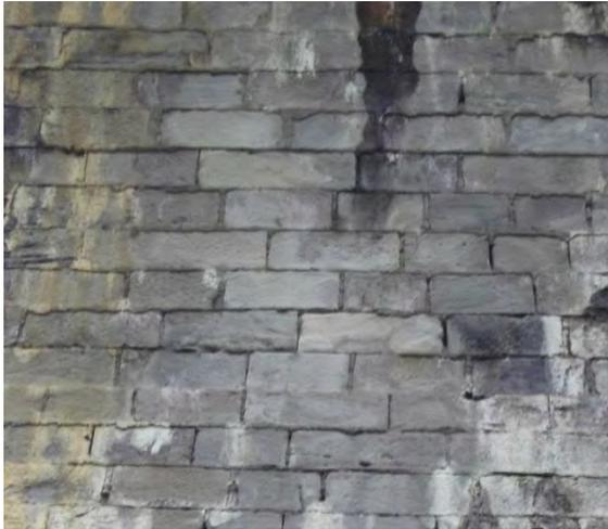
Abbildung 10: Schichtenmauerwerk Gewölbe
