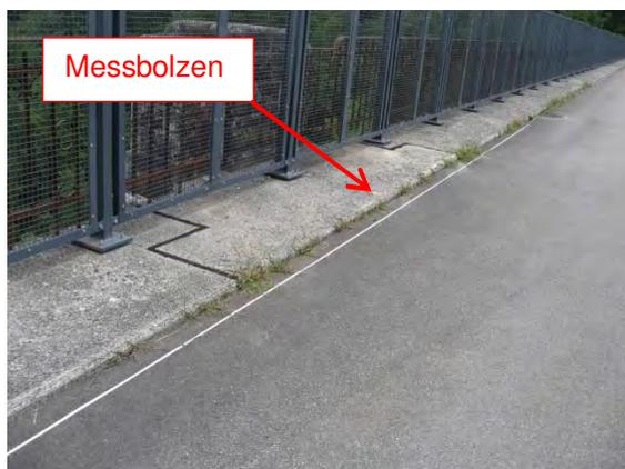
Abbildung 46: Lage eines unterwasserseitigen Messbolzens
