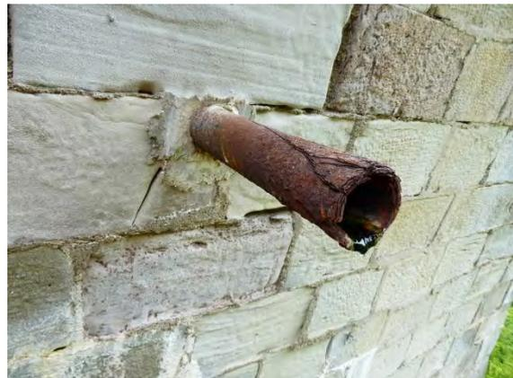
Abbildung 22: Gewölbe 4 - Nasstellen, Kalkausblühungen    Abbildung 23: Gewölbe 3 - korrosion Entwässerungsröhr
