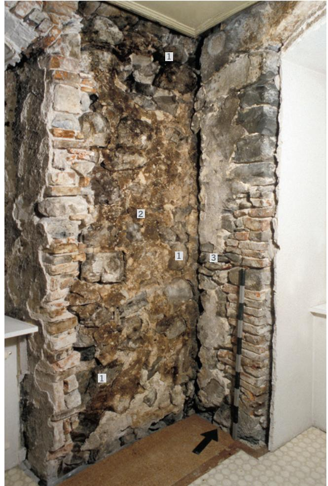
Abb. 35: Unteraltstadt 38, erstes Obergeschoss, Raum 11, Westwand, Blick nach Nordwesten. 1 Ostfassade des Steinbaus (Phase II). 2 Sanierungsverputz (Phase IV) nach Brand von Holzbau 1 (Phase III). 3 Nordfassade des «Seehofs» (Phase X).
