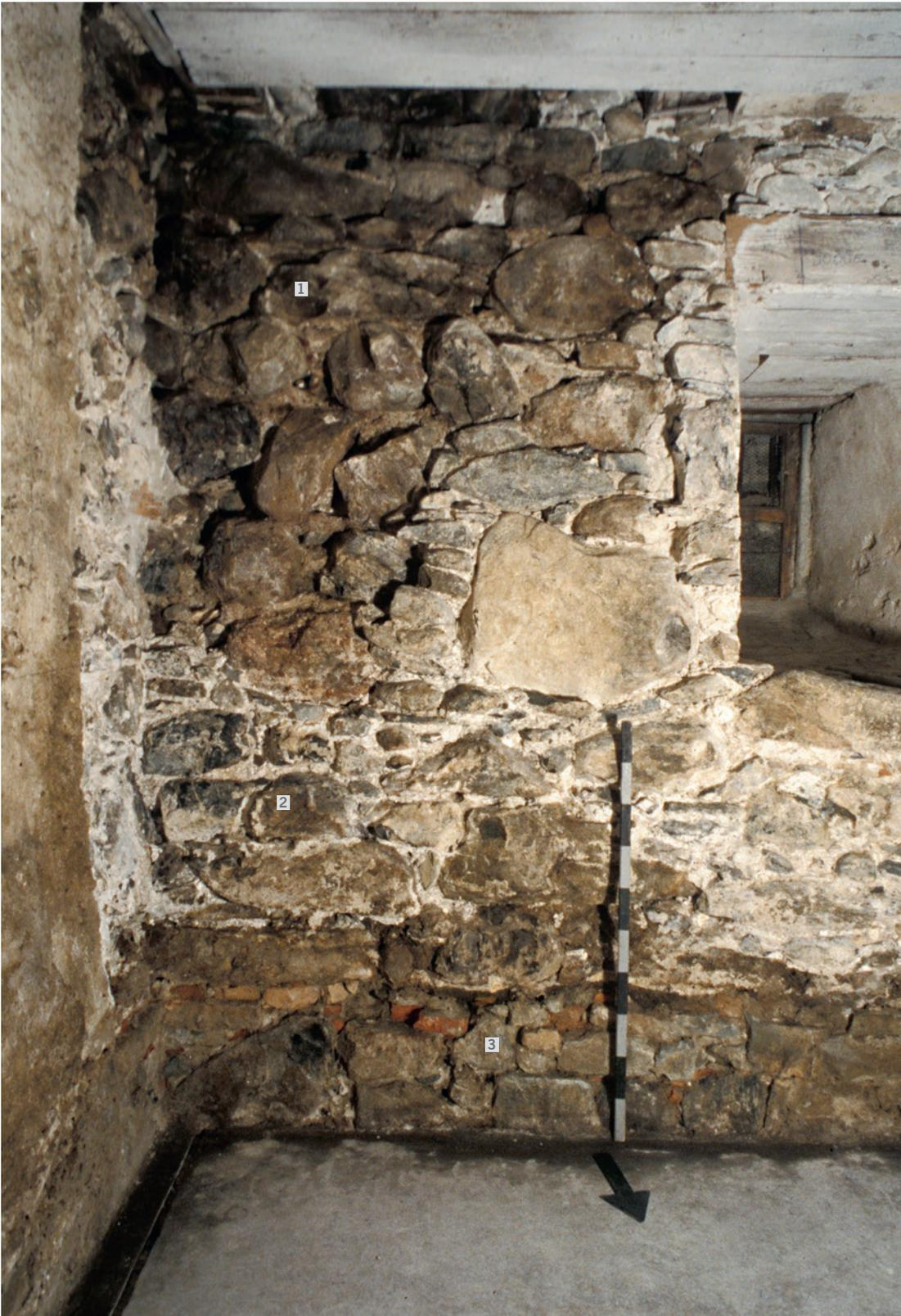
Abb. 8: Unteralstadt 38, Erdgeschoss, Raum 1, Südwand, Blick nach Süden. 1 Ringmauer mit Brandverfärbungen (Phase I). 2 Unterfangungen in Zusammenhang mit dem Bau des «Seehofs» (Phase X). 3 Unterfangung in Zusammenhang mit dem aktuellen Betonboden.
