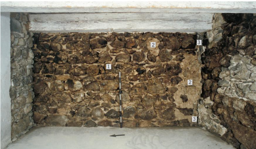
Abb. 37: Unteraltstadt 38, Zwischengeschoss, Raum 5, Ostwand, Blick nach Osten. 1 Westfassade der Liebfrauenkapelle (Phase V). 2 Sanierungsverputz (Phase VIII). 3 Vermauerter Setzungsriß (Phase X).
