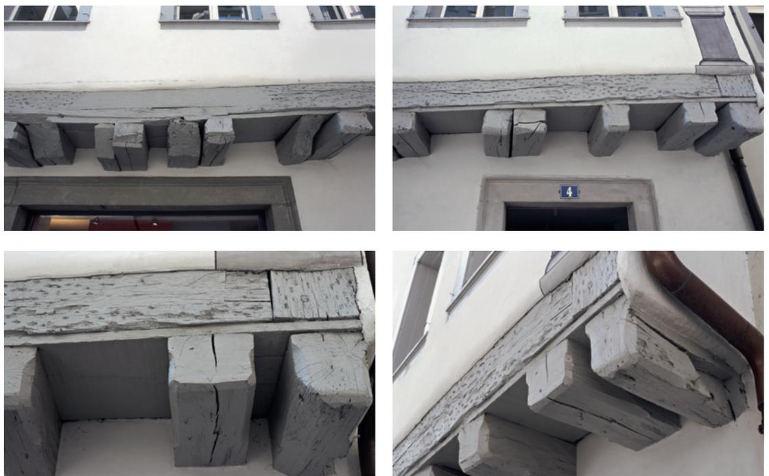
Abb. 26: Oberaltstadt 4. Ansicht der gassenseitigen Ostfassade nach dem Umbau mit vorkragenden Balkenlagen [77] des Bohlenständerbaus von 1371 sowie deren jüngere Verstärkungsbälke. Blick nach Westen.
