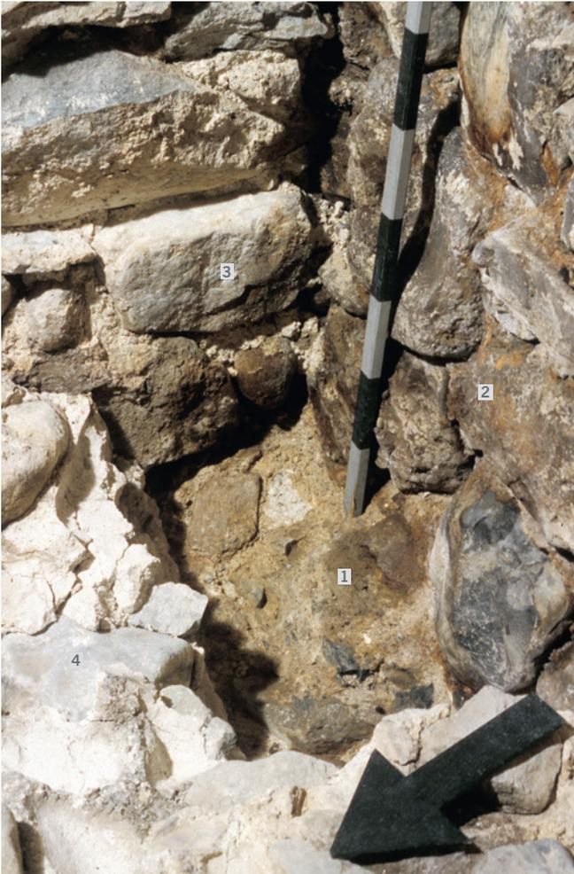
Abb. 12: Unteraltstadt 38, zweites Obergeschoss, Raum 12, Südostecke, Blick nach Südosten. 1 Ansatz der Wehrplattform an der Ringmauer (Phase I). 2 Nach Süden zurückgesetzter Teil der Ringmauer (Phase I). 3 Schwelle zum «Seehof» (Phase X) im Durchgang zur Liebfrauenkapelle. 4 Aufmauerung in Zusammenhang mit dem Bau des «Seehofs» (Phase X).
