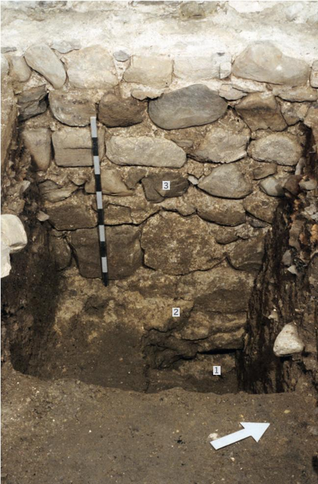
Abb. 18: Unteraltstadt 38, Erdgeschoss, Raum 4, Westwand, Blick nach Westen. 1 Fundament Ostfassade Steinbau (Phase II). 2 Fundamentabsatz (Phase II). 3 Ostfassade Steinbau (Phase II).
