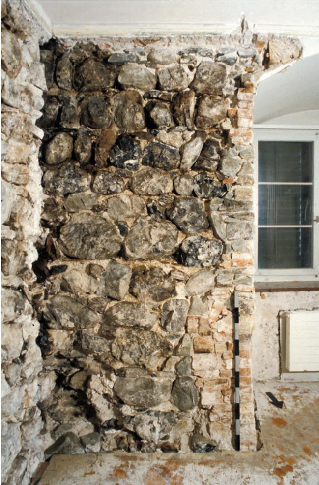
Abb. 10: Unteraltstadt 38, erstes Obergeschoss, Raum 6, Südwand, Blick nach Süden. Die Brandschäden an der Ringmauer (braune Verfärbungen, abgeplatzte Steinköpfe) sowie der Wechsel der Steingrößen lassen sich auf diesem Bild deutlich erkennen (Phase I).
