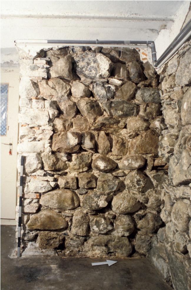
Abb. 22: Unteraltstadt 38, Erdgeschoss, Raum 1, Westwand, Blick nach Westen. Ostfassade des Steinbaus (Phase II). Bei diesem Mauerteil fallen besonders die sauber gefügten Steinlagen auf.
