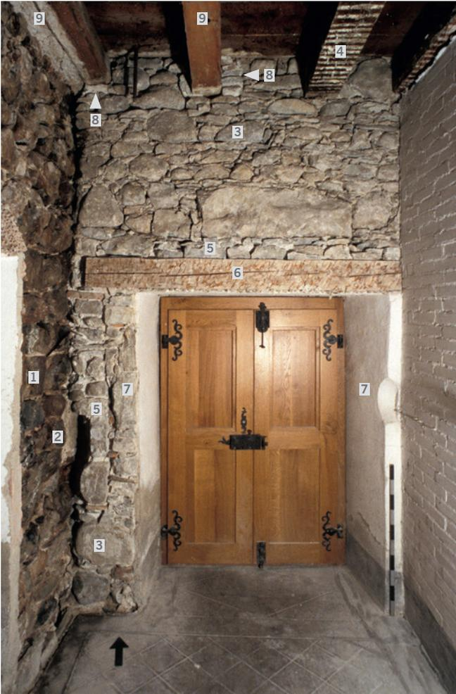
Abb. 34: Unteraltstadt 38, Erdgeschoss, Raum 4, Westwand, Blick nach Nordwesten. 1 Ostfassade des Steinbaus (Phase II). 2 Sanierungsverputz (Phase IV). 3 Nordfassade des «Seehofs» (Phase X). 4 Deckenbalken (Phase X) 5 Flick zu Fenster in Zusammenhang mit Umbau 1 (Phase XI). 6 Holzsturz zu Fenster (Phase XI). 7 Laibungsflick zu neuer Tür von Umbau 2 (Phase XII). 8 Balkenflick zu 9 (Phase XII). 9 Deckenbalken Umbau 2 (Phase XII).
