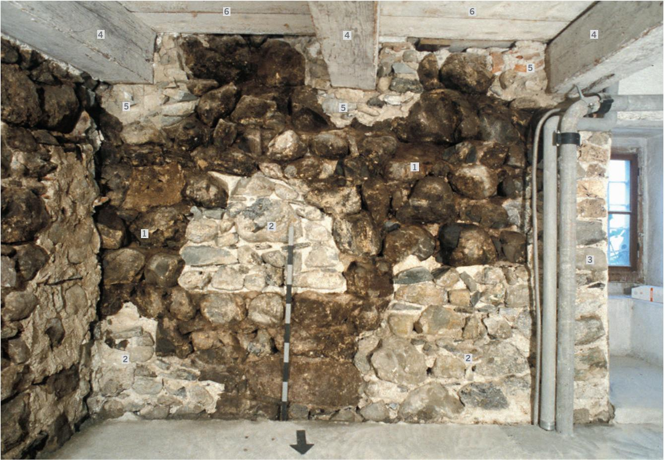
Abb. 9: Unteraltstadt 38, Zwischengeschoss, Raum 5, Südwand, Blick nach Süden. 1 Ringmauer (Phase I). Auf der Höhe der Flickstellen 5 setzt die grosssteinige Mauerpartie der Ringmauer an. 2 Flickstellen in Zusammenhang mit dem Bau des «Seehofs» (Phase X). 3 Östliche Laibung der Fensternische zum «Seehof» (Phase X). 4 Tiefer gelegte Bodenbalken zu Umbau 2 im ersten Obergeschoss (Phase XII). 5 Balkenflicke zu Umbau 2 (Phase XII). 6 Bodenbretter zu Umbau 2 im ersten Obergeschoss (Phase XII).
