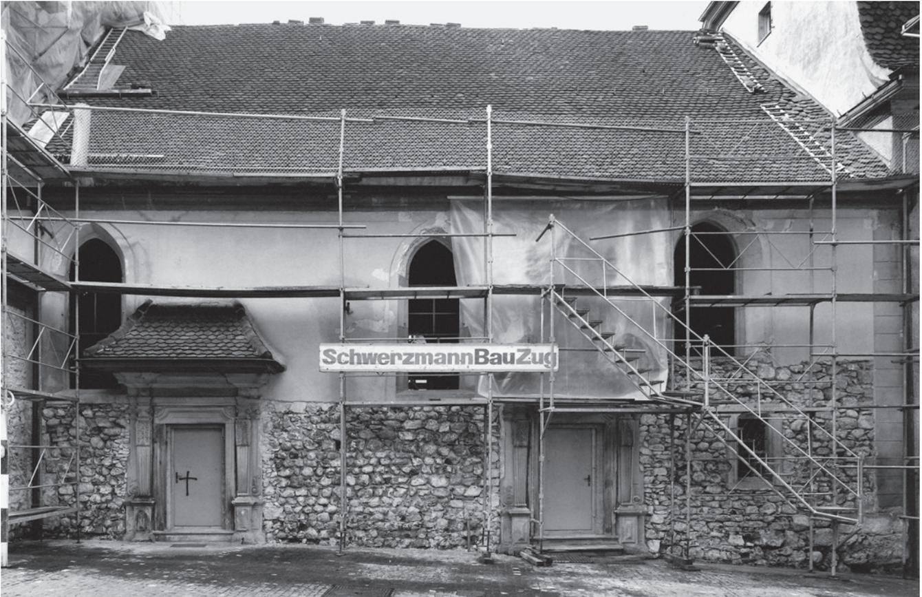
Abb. 42: Unteraltstadt, Liebfrauenkapelle, Nordfassade, Blick nach Süden. Aufnahme vom 3. August 1982 mit freigelegtem Originalmauerwerk. Am rechten Bildrand sind im unteren Bereich des Mauerwerks grosse Eckquader zu erkennen, welche die Nordwestecke der Kapelle bilden. Leicht verdeckt von den Gerüststangen am linken Bildrand sind Gewändesteine eines vermutlich originalen Zugangs sichtbar. Die beiden heutigen Portale sind jünger im Mauerwerk versetzt.
