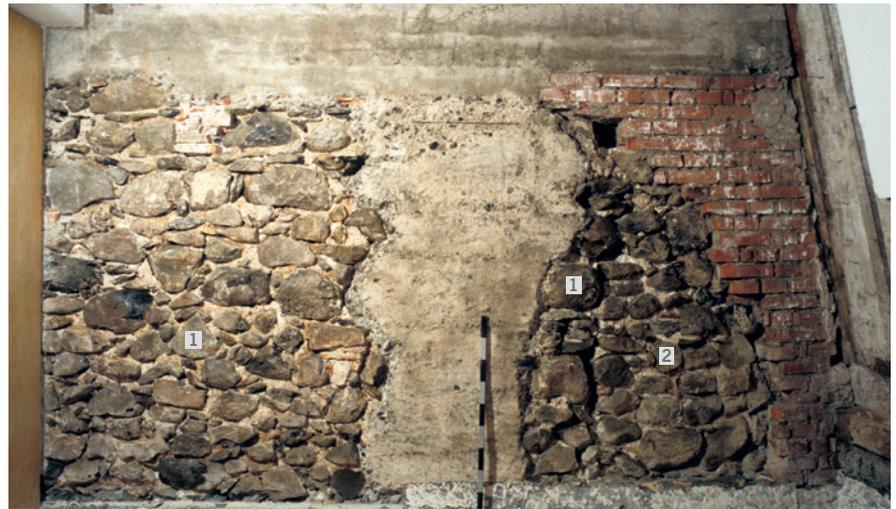
Abb. 39: Unteralstadt 38, drittes Obergeschoss, Raum 19, Ostwand, Blick nach Osten. 1 Westfassade der Liebfrauenkapelle (Phase V). 2 Übermauerung eines Holzsturzes über dem Durchlass für den Wehgang zur Sanierung der Kapelle (Phase VIII).
