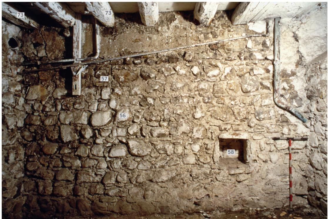
Abb. 21: Oberaltstadt 4. Ansicht der Mauer [56] von innen mit der Lichternische [58]. Blick nach Süden.
