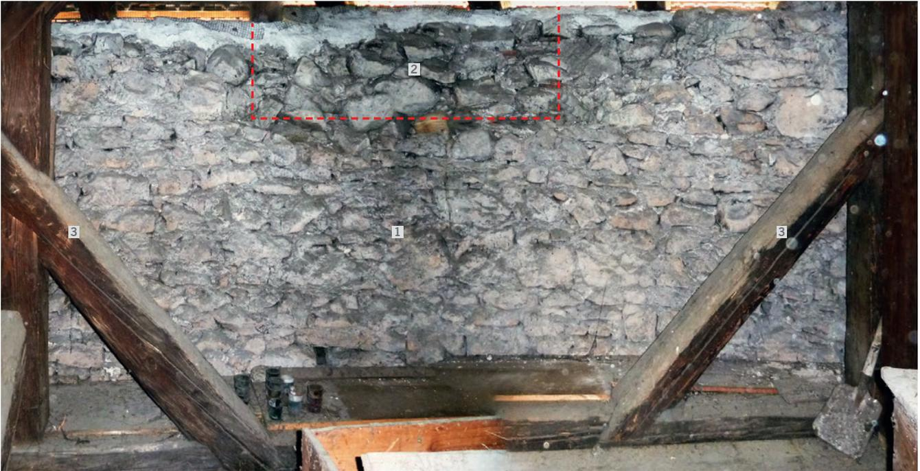
Abb. 50: Unteraltstadt, Liebfrauenkapelle, Südwand, Blick nach Süden. Aus zwei Einzelbildern zusammengesetzte Aufnahme der Ringmueraufhöhung. 1 Aufhöhung der Ringmuer (Phase VII). Die gut sichtbaren rötlichen Verfärbungen sind Folgen eines Brandes. Die Rekonstruktion einer Zinnenöffnung ist rot gestrichelt dargestellt. 2 Zumauerung der Zinnenöffnung in Zusammenhang mit Dachstuhl der Liebfrauenkapelle (Phase IX). 3 Teile der Dachkonstruktion von 1433 (Phase IX).
