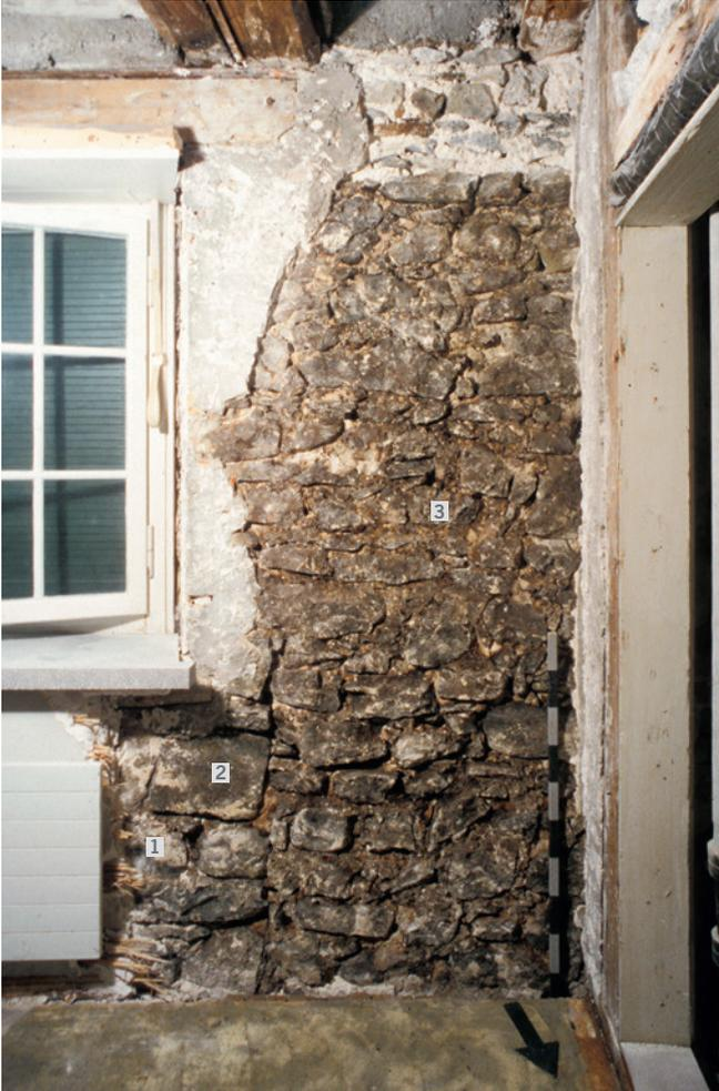
Abb. 14: Unteraltstadt 38, zweites Obergeschoss, Raum 13, Südwand, Blick nach Süden. 1 Ringmauer (Phase I). 2 Zinnenansatz an Ringmauer 1 (Phase I). 3 Aufhöhung der Ringmauer 1 (Phase VII).
