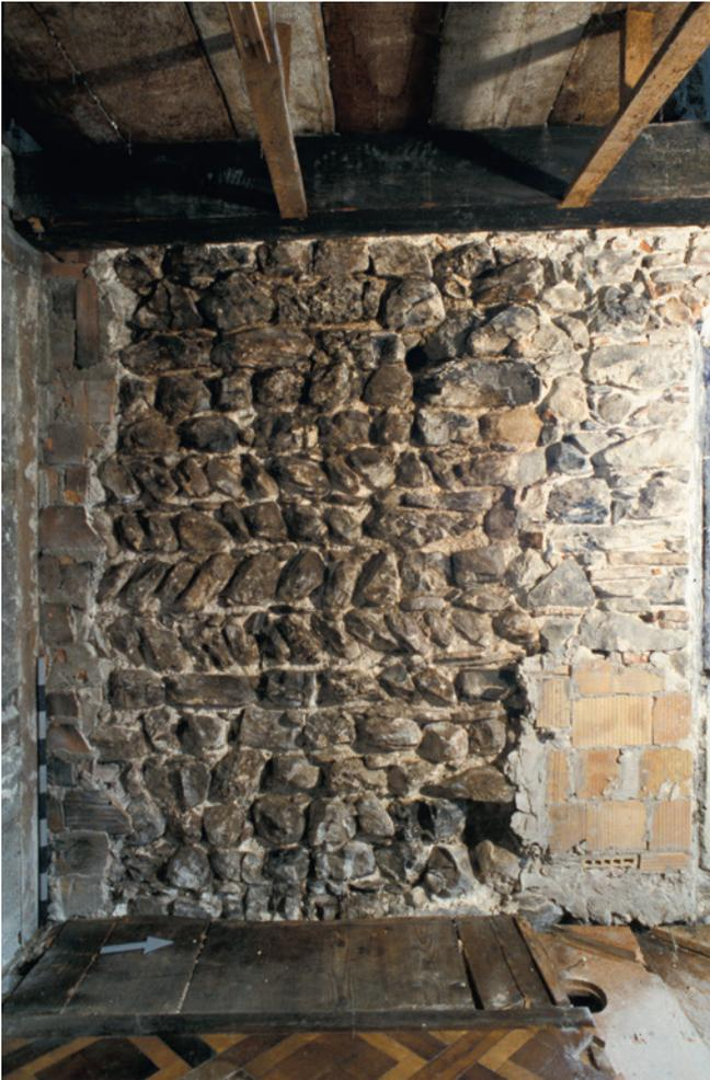
Abb. 24: Unteraltstadt 38, erstes Obergeschoss, Raum 11, Westwand, Blick nach Westen. Ostfassade des Steinbaus mit beeindruckend sauber gefügten Steinlagen; speziell ist auch die mit schräg gestellten Steinen gefügte Mauerpartie in der Bildmitte (Phase II).
