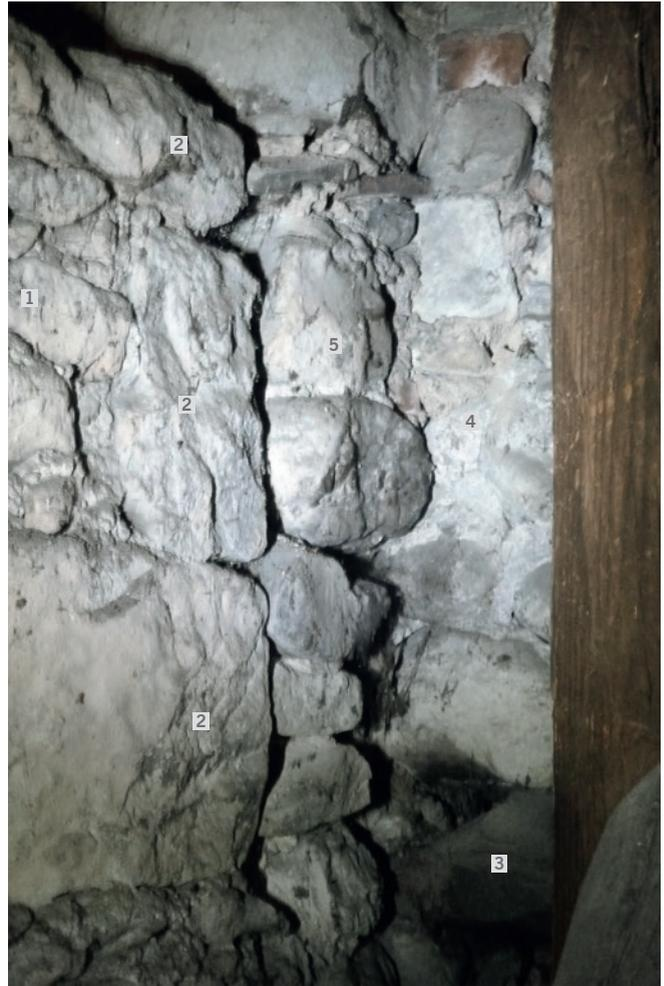
Abb. 49: Unteraltstadt, Liebfrauenkapelle, Dachstuhl. Blick in die Südwestecke. 1 Aufhöhung der Ringmauer (Phase VII). 2 Quadersteine als westlicher Zinnenabschluss (Phase VII). 3 Holzsturz, dendrodatiert 1371, in Zusammenhang mit Holzbau 3 und Sanierung der Liebfrauenkapelle (Phase VIII). 4 Übermauerung auf 3 (Phase VIII). 5 Jüngere Zumauerung in Zusammenhang mit Dachstuhl der Liebfrauenkapelle (Phase IX).
