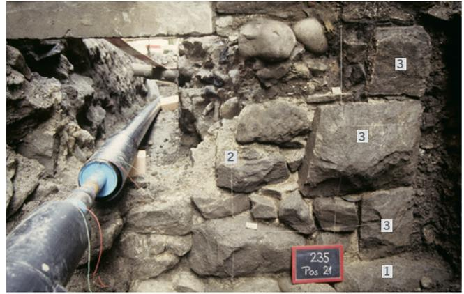
Abb. 27: Unteraltstadt 38. Ansicht der Nordostecke des Steinbaus (Phase II) im Leitungsgraben der Fernheizung. Blick nach Westen. 1 Fundamentabsatz. 2 Aufgehendes Mauerwerk. 3 Eckquader.
