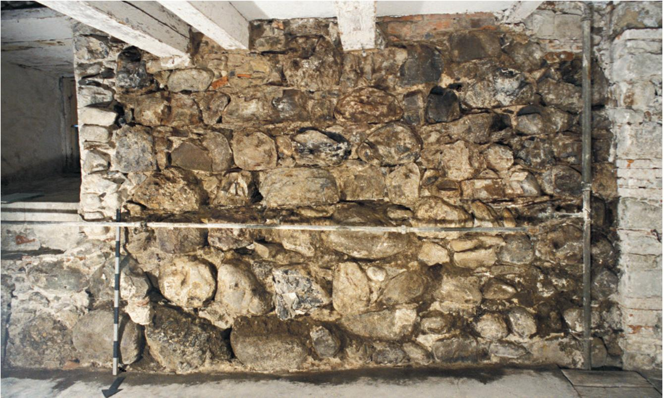
Abb. 7: Unteralstadt 38, Erdgeschoss, Raum 1, Südwand, Blick nach Süden. Der Absatz zwischen Fundament und aufgehendem Mauerwerk der Ringmauer (Phase I) liegt unmittelbar oberhalb der horizontal verlaufenden Wasserleitung.
