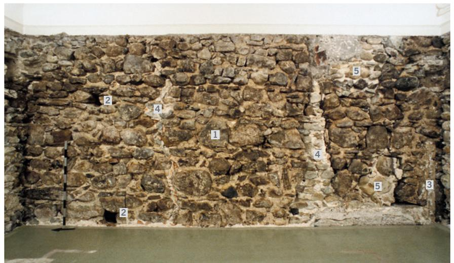
Abb. 40: Unteralstadt 38, zweites Obergeschoss, Raum 16, Ostwand, Blick nach Osten. 1 Westfassade der Liebfrauenkapelle (Phase V). 2 Negative von Gerüststangen (Phase V). 3 Mörtelstreifen mit Negativ von Holzpfeilen (Phase VIII). 4 Setzungsrisse, die mit dem Bau des «Seehofs» zugemauert wurden (Phase X). 5 Flickstellen zur Sanierung des Kapellenmauerwerks (Phase X).
