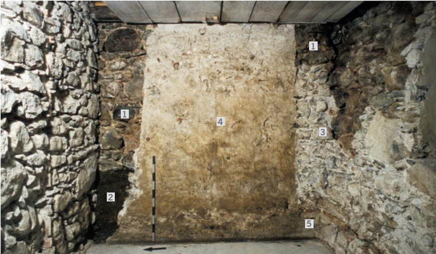
Abb. 36: Unteraltstadt 38, Erdgeschoss, Raum 1, Ostwand, Blick nach Osten. 1 Westfassade der Liebfrauenkapelle (Phase V). 2 Dunkelbraune Lehmschicht (gewachsener Boden) 3 Unterfangung in Zusammenhang mit dem «Seehof» eingebaut (Phase X). 4 Verputz im Zusammenhang mit dem Bau des «Seehofs» (Phase X). 5 Unterfangung in Zusammenhang mit dem aktuellen Betonboden.
