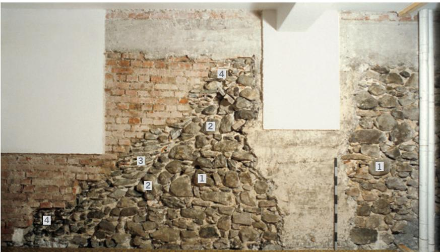
Abb. 38: Unteraltstadt 38, drittes Obergeschoss, Raum 23, Ostwand, Blick nach Osten. 1 Westfassade der Liebfrauenkapelle; nördliches Ende ist wohl als Dachschräge zu interpretieren (Phase V). 2 Aufmauerung zur Sanierung der Kapelle (Phase VII). 3 Aufmauerung in Zusammenhang mit dem 1433 erstellten Dachstuhl der Liebfrauenkapelle (Phase IX). 4 Aufmauerung zwischen dem Dach der Liebfrauenkapelle und dem höher liegenden Dachsparren des «Seehofs» (Phase X).
