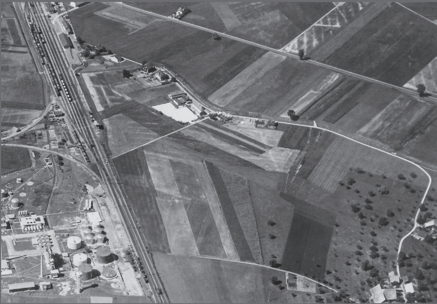
Flugaufnahme um 1945, im Vordergrund die IPSA AG (erste Erdöl-Raffinerie der Schweiz) und das Suurstoffi-Areal rechts der Bahnlinie
