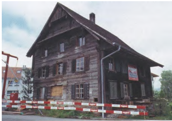
Holzhäusernstrasse 2: Das 1470 errichtete Wohnhaus, Ansicht von Nordosten, während des Umbaus 2005
