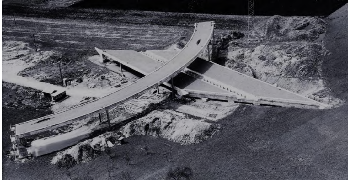
1970: Verlassen auf einer Wiese steht die Verzweigung Holzhäusern, wo die A 4 und die A 14 zusammentreffen. Aus bautechnischen Gründen mussten zuerst die Kunstbauten errichtet werden, erst dann konnte mit dem eigentlichen Strassenbau begonnen werden.
