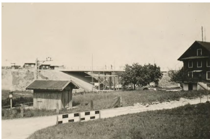
Bau der Strassenüberführung der SBB-Geleise bei der Unterrüti 1959, rechts Haus Meier
