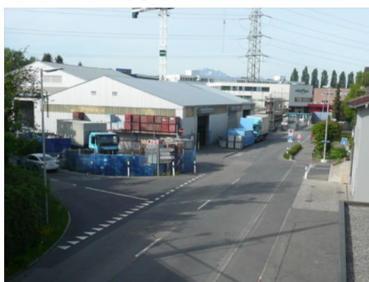
Abbildung 11: Knotensituation bei der Altgasse, Höhe Twerenbold Entsorgung
