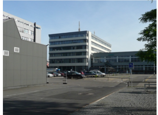
Abbildung 20: Dammstrasse, Höhe Shedhalle Club Fabric
