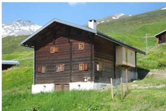
Die Talfassade des Nüw Hus
