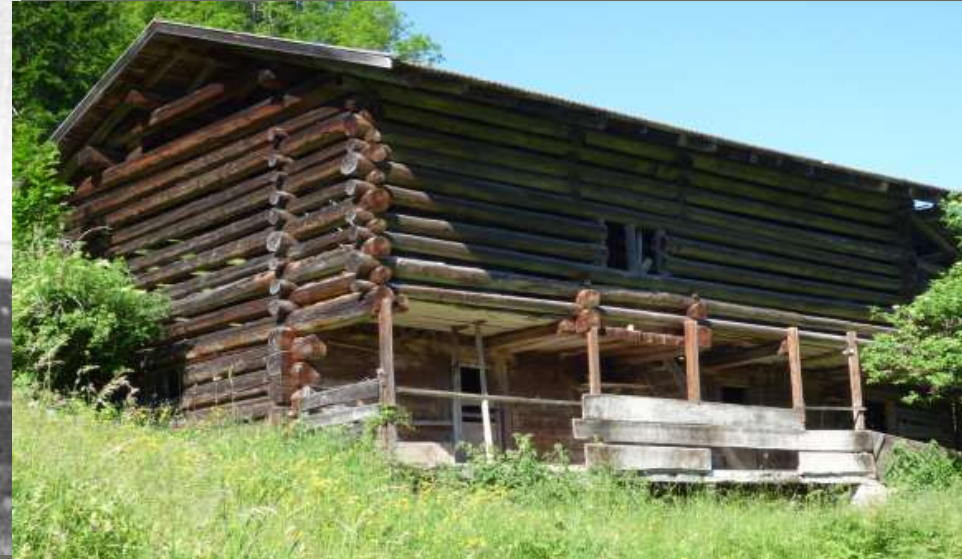
Traufseitig auskragende Stall-scheune in Rund- und Kantholzblock (Cunters, GR)
