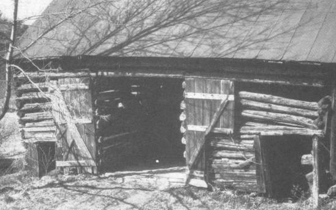
Grundscheier bei Fleetwood, Berks County, Pennsylvania. Mitte 18. Jh. Rundholzblock mit zwei Heuräumen. (Aus: Ensminger 2003, S. 7)
