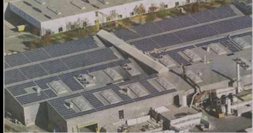
Die neue Solaranlage am Thöni-Werksdach in Kempten: Die 1-MW-Anlage deckt 40 % des Strombedarfs. Foto: Thöni
