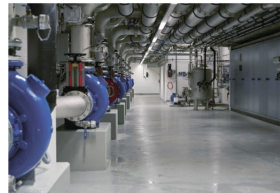
Neuer Leitungsgang mit neuen Rücklaufschlammumpwerken (blau)
